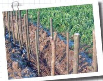
Il faut réaliser un joint de terre à la base de la fascine pour que l'eau ne crée pas de circuits préférentiels.
